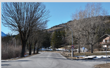
> Aménagement de l'entrée Est de la ville
