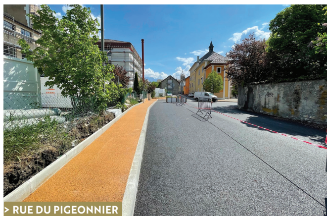
> RUE DU PIGEONNIER
